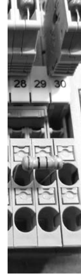
Նկար 7 Դիմադրության (ռեզիստորի) տեղադրման օրինակ
