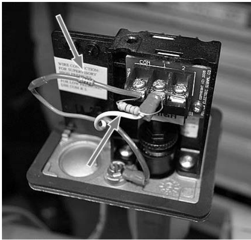
Նկար 6 ճնշման ռելեի հեռամարմնում դիմադրությունների (ռեզիստորների) տեղադրման օրինակ
