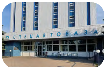
ГУП Водоканал, г. Санкт-Петербург
