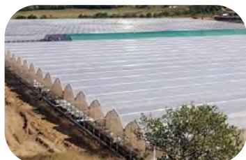
Теплицы СХП Кавказ, Ставропольский край
