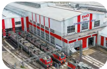
Ремонтное депо РЖД, г. Чита
