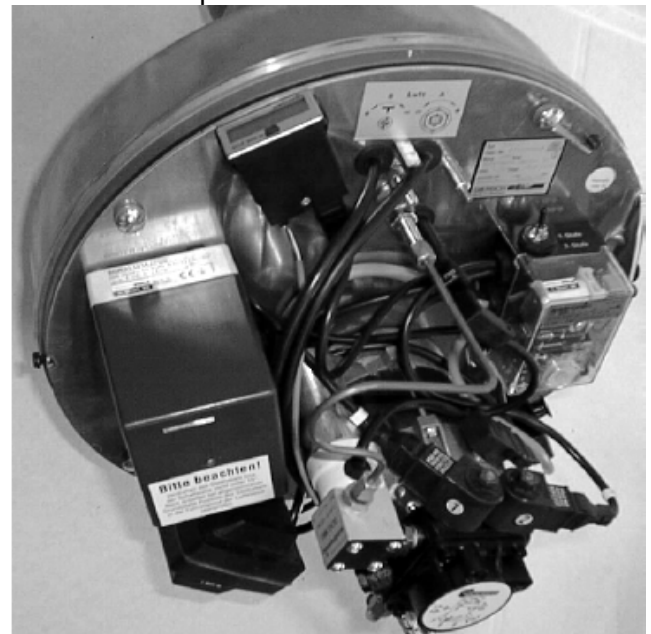
рис.2 Монтаж на R20
