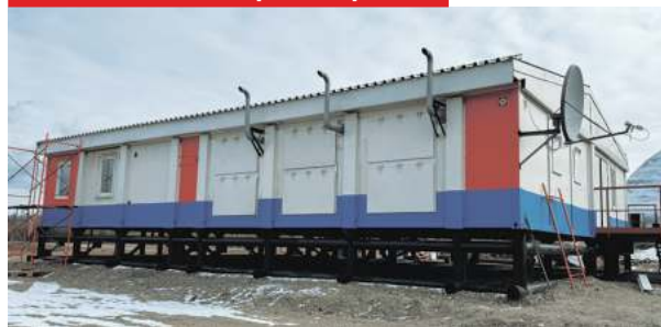
АГЭК Оймякон. Энергоцентр
