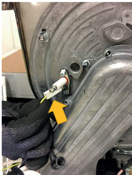
Электрод Зажигания
