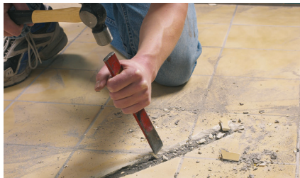
5. Штробление канала и установка гофротрубки для датчика
