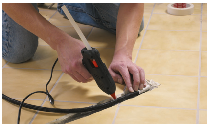
7. Фиксация гофротрубки
