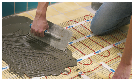
12. Затирка плиточным клеем
