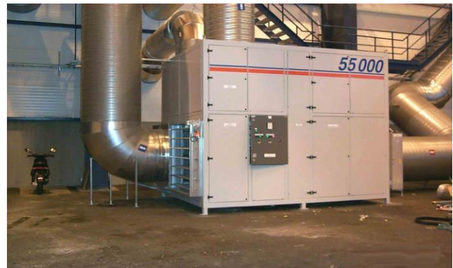
Склад металлических изделий. Осушитель DT55000 с воздушным потоком 55 000 м 3 /ч
