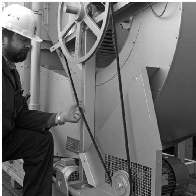
Рисунок 1: Регулировка ремня вентилятора
