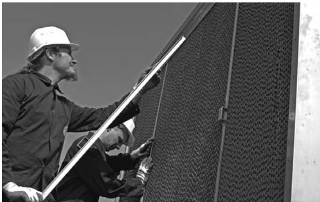
Рисунок 12: Снятие Т-профилей (Т-профили опционные)
