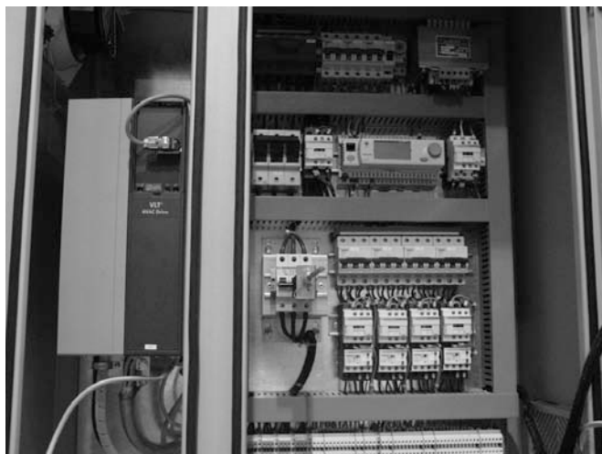
Рисунок 3: Панель управления с частотно-регулируемым приводом
