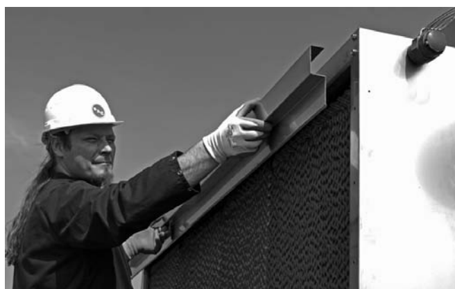
Рисунок 11: Снимите верхнюю пластину
