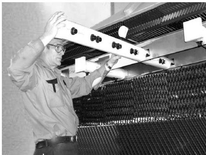
Рисунок 11: Съемная оросительная система
