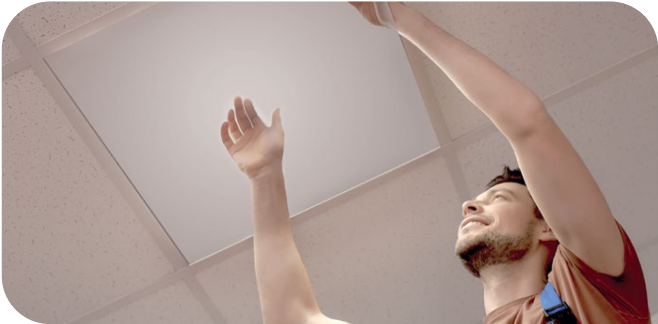
Незаметный монтаж в любые подвесные потолки с ячейкой 600х600 мм
