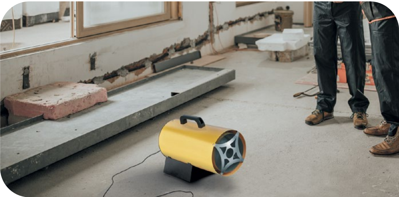
Эффективный быстрый обогрев при проведении ремонтных работ
