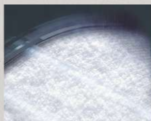
Обмерзание теплообменника
