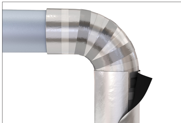
Рисунок 65: Установка первого сегмента на отводе
