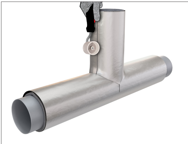
Рисунок 76: Фиксация соединений валиком
