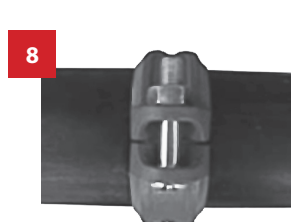
Визуальный контроль соединения
