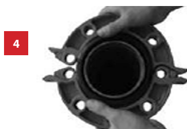
Установить корпус фланца
