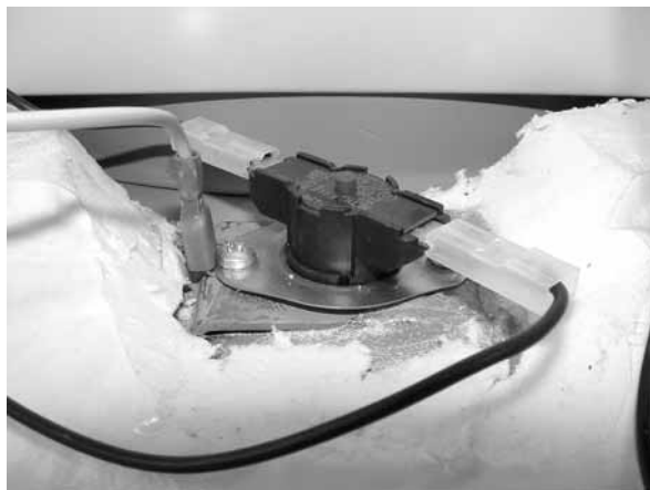
Рис. 26: Кнопка включения предохранительного термостата
