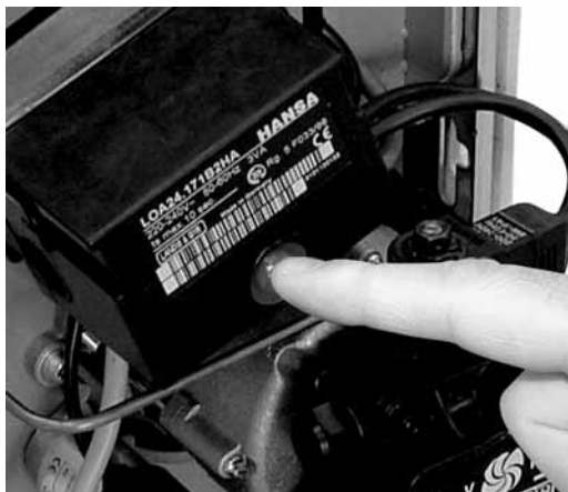
Рис. 25: ACV BM 1 LN 1 кнопка перезапуска жидкотопливной горелки
