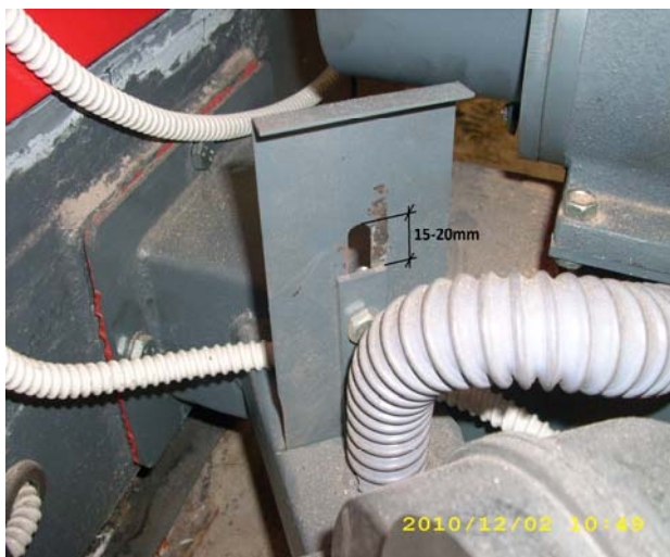
Рисунок 7. Положение клапана вентилятора
