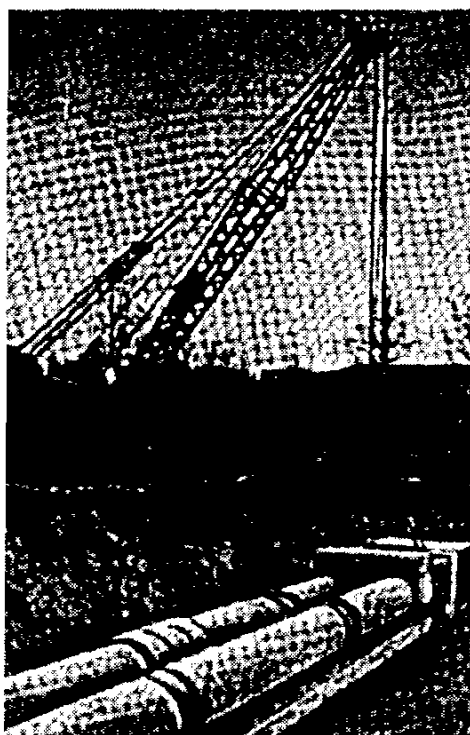
Рис. 6.16. Монтаж непроходного канала теплосети с применением монолитного лоткового канала (МКЛ для труб диаметром 50–1400 мм) с помощью автокрана грузоподъемностью 28 т
