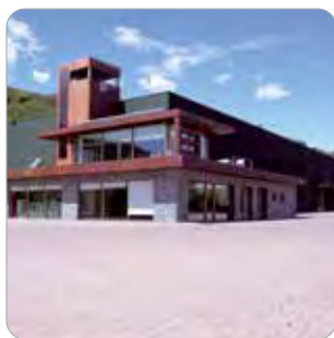
NEW PRODUCTION UNIT San Maurizio d'Opaglio (NO)
