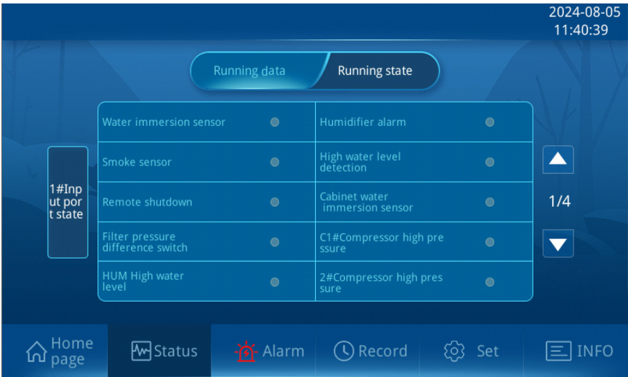
Рисунок 3.13 Меню Рабочее состояние 1
