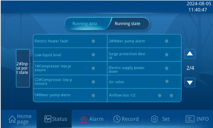
Рисунок 3.14 Меню Рабочее состояние 2
