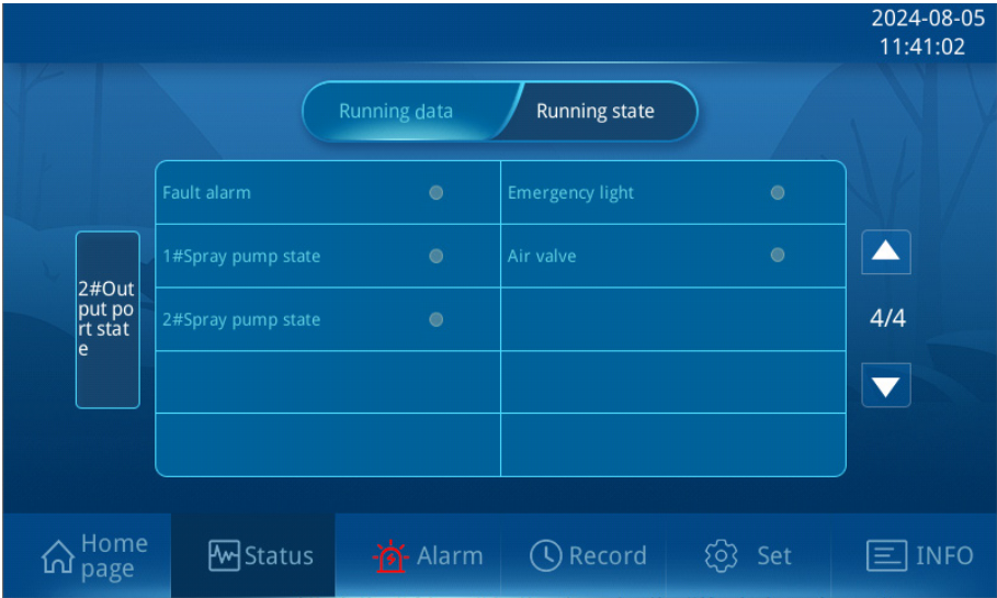
Рисунок 3.16 Меню Рабочее состояние 4
