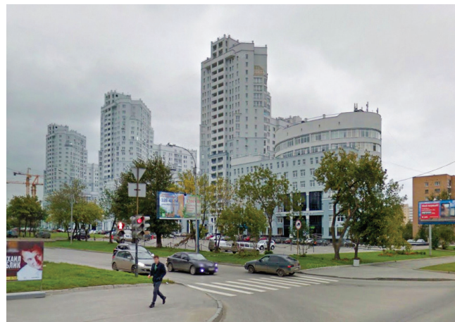
БИЗНЕС-ЦЕНТР «ТАТИЩЕВСКИЙ» Екатеринбург, 500 кВт
