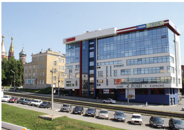
БИЗНЕС-ЦЕНТР «НАЙДИ» Ижевск, 498 кВт
