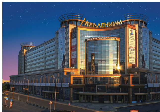
ТОРГОВЫЙ ЦЕНТР «МИЛЛЕНИУМ» Омск, 410 кВт
