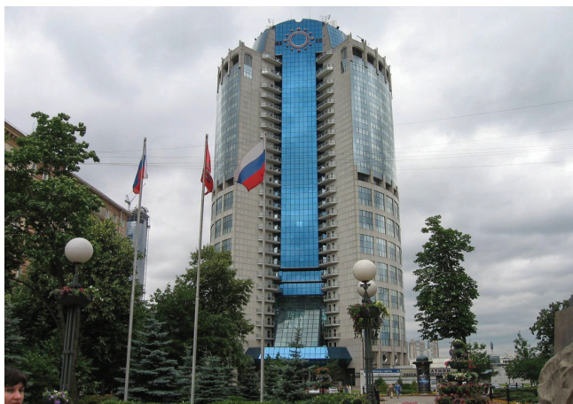
ГУП «МОСВОДОСТОК» Москва, 440 кВт
