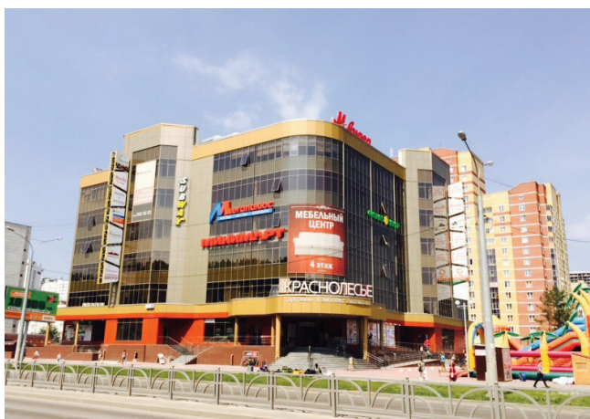
ТОРГОВЫЙ ЦЕНТР «КРАСНОЛЕСЬЕ» Екатеринбург, 700 кВт
