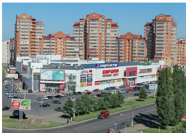
ТОРГОВЫЙ ЦЕНТР «ЕВРОПА 26» Железногорск, 320 кВт
