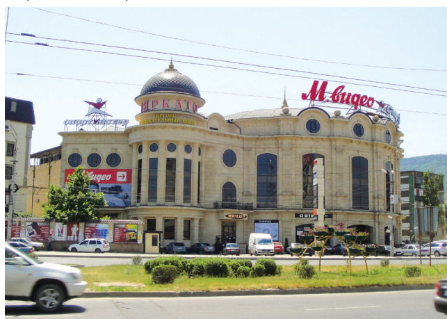
ТОРГОВЫЙ ЦЕНТР «МИРКАТО» Махачкала, 590 кВт
