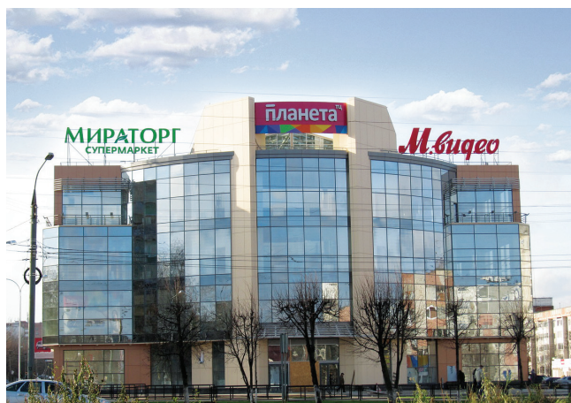
ТОРГОВЫЙ ЦЕНТР «ПЛАНЕТА» Йошкар-Ола, 836 кВт
