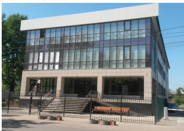
КОЛ-ЦЕНТР «ТЕЛЕ2» Иркутск, 300 кВт
