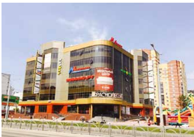
ТОРГОВЫЙ ЦЕНТР «КРАСНОЛЕСЬЕ» Екатеринбург, 700 кВт
