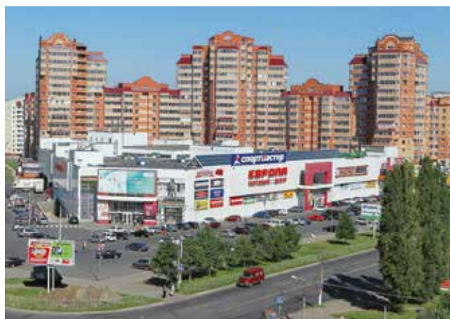
ТОРГОВЫЙ ЦЕНТР «ЕВРОПА 26» Железногорск, 320 кВт
