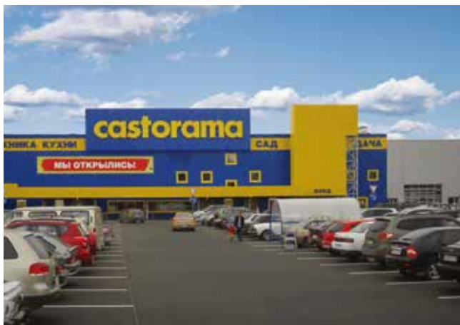
ГИПЕРМАРКЕТ СТРОИТЕЛЬНЫХ ТОВАРОВ «КАСТОРАМА» Уфа, 1 МВт
