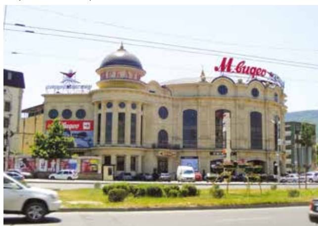
ТОРГОВЫЙ ЦЕНТР «МИРКАТО» Махачкала, 590 кВт
