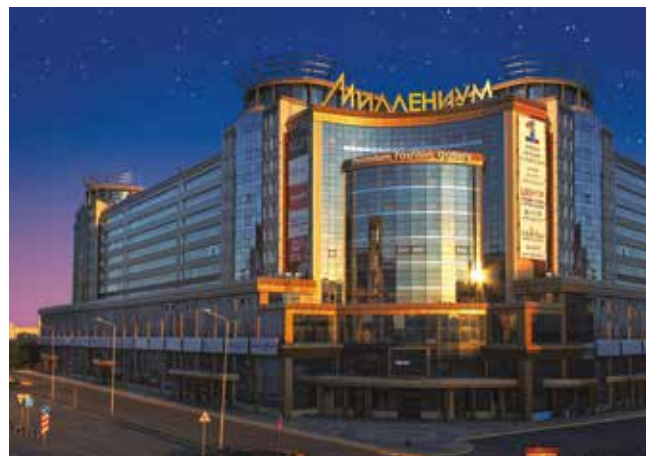
ТОРГОВЫЙ ЦЕНТР «МИЛЛЕНИУМ» Омск, 410 кВт
