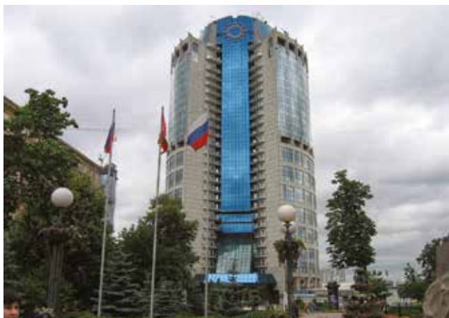
ГУП «МОСВОДОСТОК» Москва, 440 кВт
