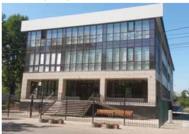
КОЛ-ЦЕНТР «ТЕЛЕ2» Иркутск, 300 кВт
