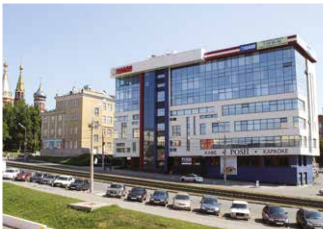
БИЗНЕС-ЦЕНТР «НАЙДИ» Ижевск, 498 кВт
