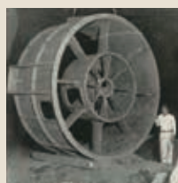
Литье крупных изделий; туннельный вентилятор
