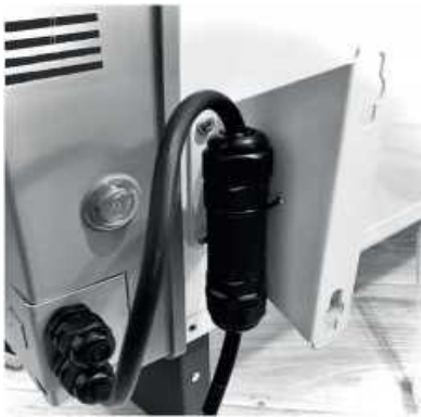
Рисунок 4 - Крепление кабеля на кронштейне конвектора
