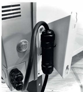
Рисунок 4 - Крепление кабеля на кронштейне конвектора
