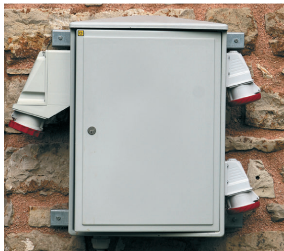
Рис. 1.18. Наружный герметичный щит, на корпусе смонтированы силовые разъемы: слева — трехфазный; справа — однофазные
