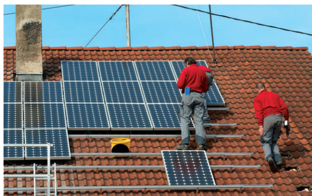
Рис. 2.11. Монтаж фотоэлектрической батареи
