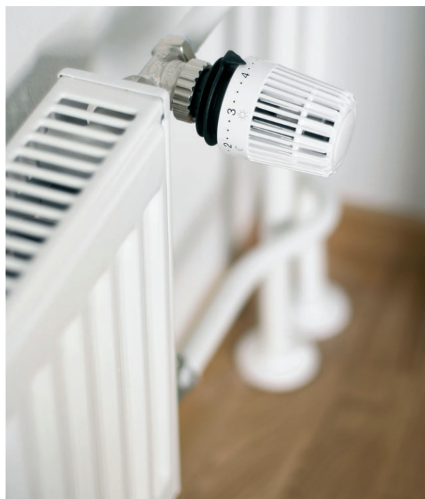
Рис. 11.34. Некоторые виды радиаторов позволяют регулировать температуру воздуха в отдельно взятом помещении
