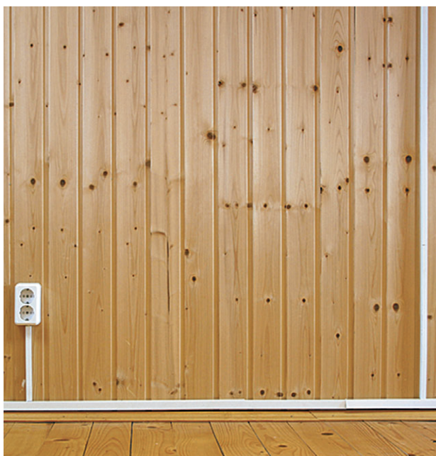
Рис. 1.19. Открытая электропроводка в деревянном доме в пластиковых кабель-каналах поверх деревянной обшивки
