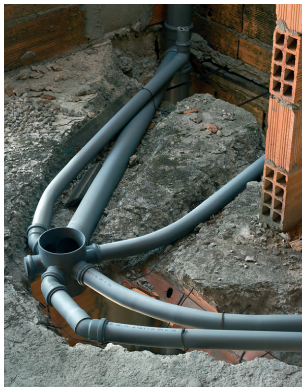
Рис. 4.19. Прокладка труб холодного водопровода под землей
