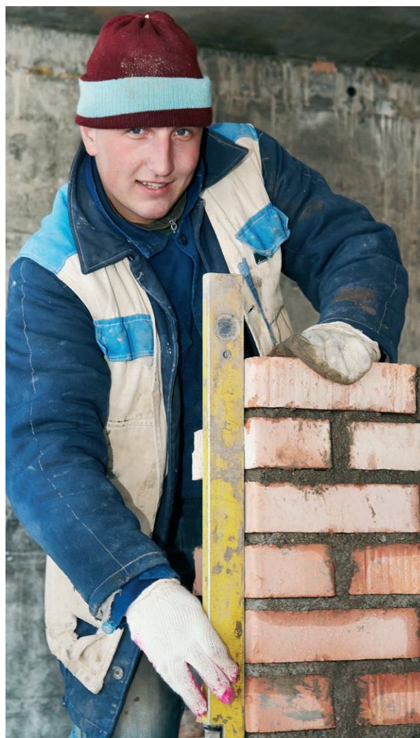
Рис. 10.33. Контроль кладки уровнем
