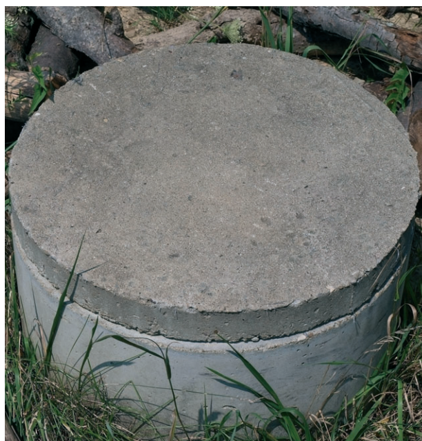
Рис. 8.11. На поверхности размещается только крышка септика
