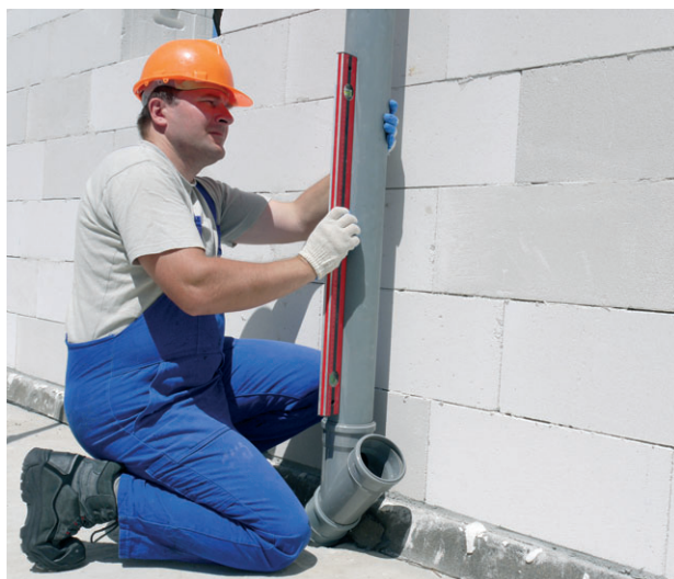
Рис. 5.11. Сборка канализационного стояка
