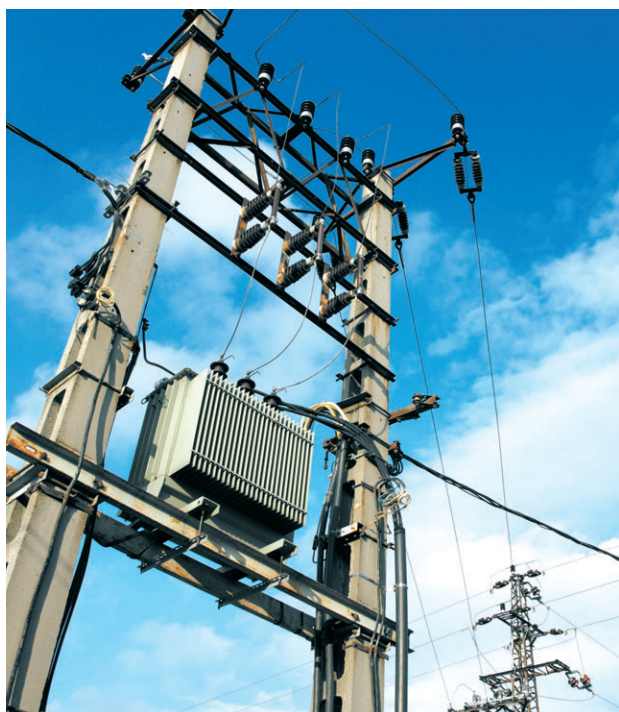
Рис. 1.35. Трансформаторные подстанции
