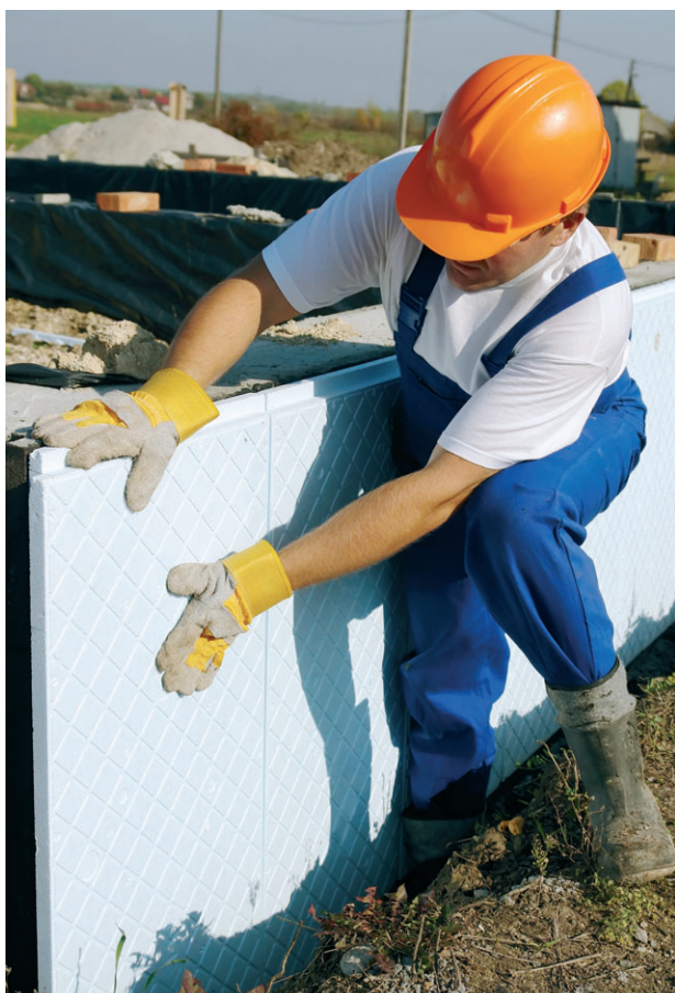
Рис. 9.6. Утепление фундамента плитами из экструдированного пенополистирола
