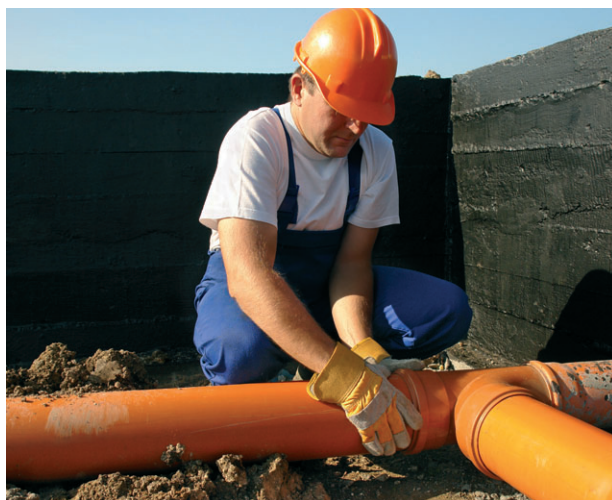
Рис. 5.12. Для внутренней канализации дома выбирайте пластиковые трубы, стойкие к агрессивным средам
