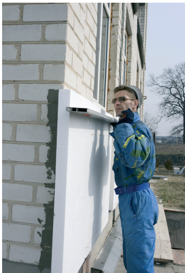
Рис. 9.7. Наружная обшивка стен дома плитами из пенополиэтилена
