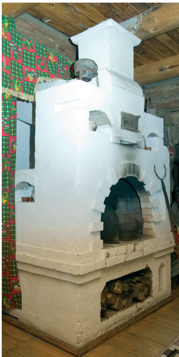
Рис. 10.4. Рациональное размещение печи (близко к капитальной стене в доме)
