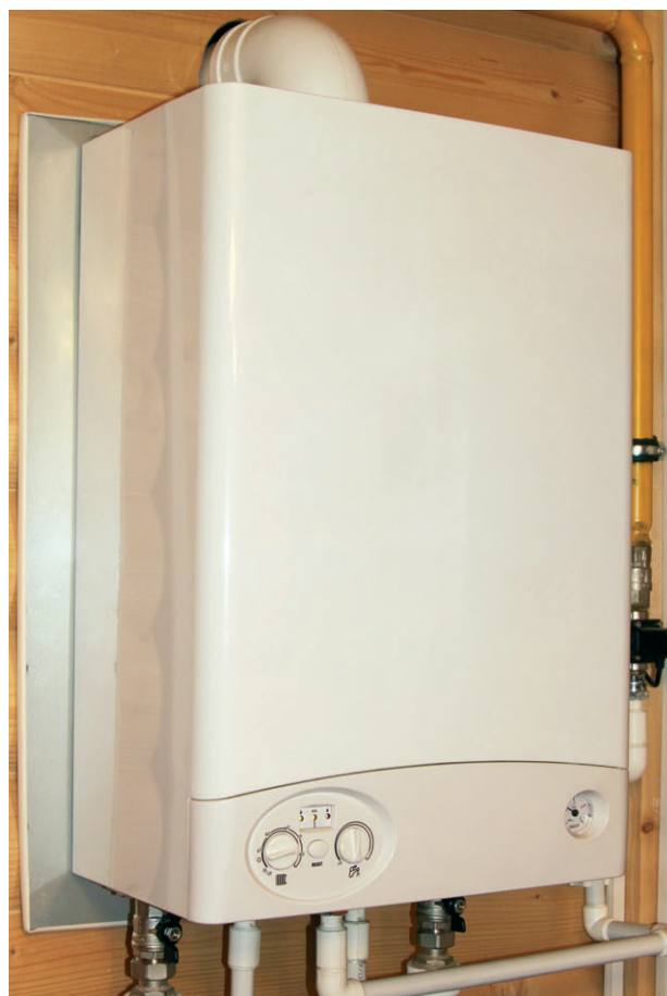
Рис. 6.6. Современная газовая водогрейная колонка
