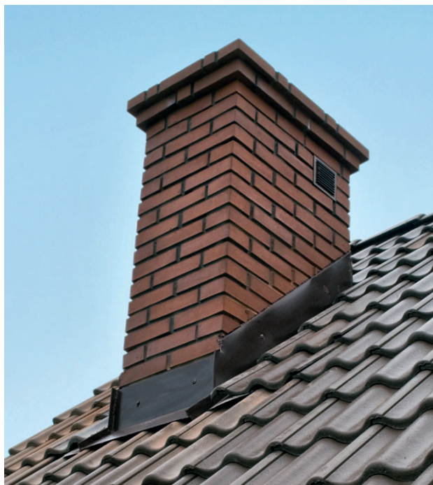
Рис. 10.39. Возведение насадной трубы
