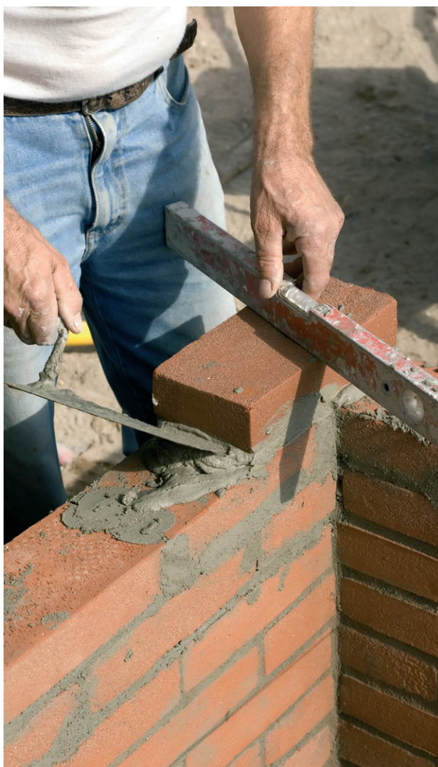
Рис. 10.32. Нанесение раствора
