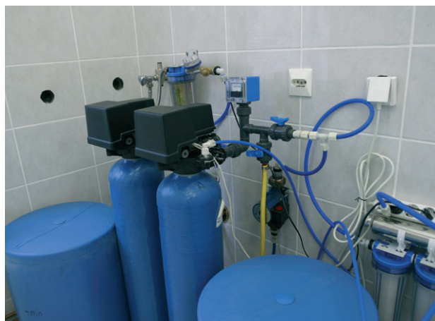
Рис. 3.30. Система многоступенчатой очистки воды
