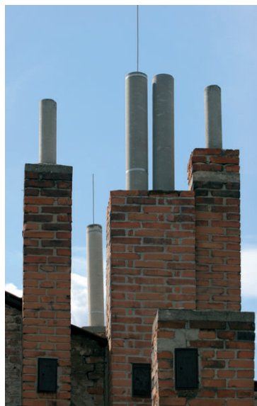
Рис. 10.50. Асбестовые трубы, обложенные кирпичом
