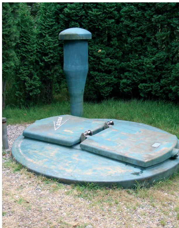
Рис. 8.12. Фильтрующий колодец
