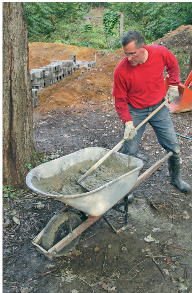
Рис. 10.27. Для приготовления раствора специальные средства не нужны
