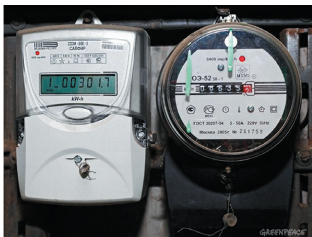
Рис. 1.17. Приборы учета электроэнергии: a — современный электросчетчик; б — опломбированные электросчетчики (внизу видна пломба, которую поставил электрик после установки прибора)
