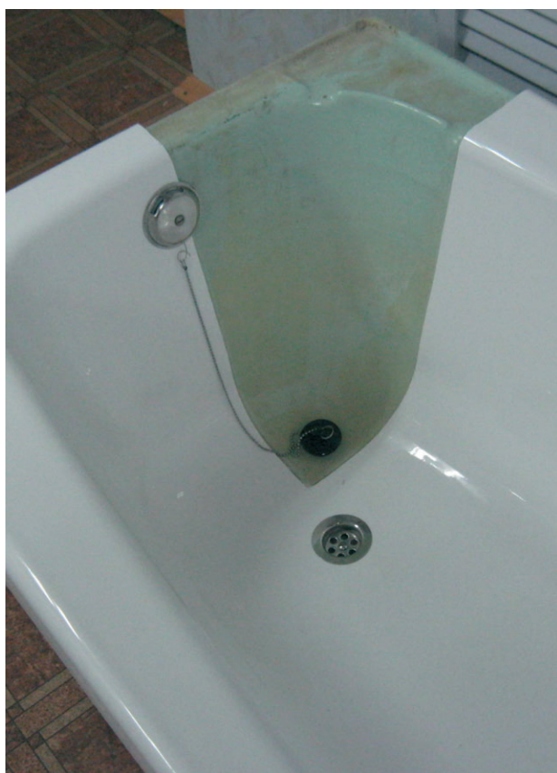
Рис. 5.2. Реставрация ванны с помощью наливного акрила
