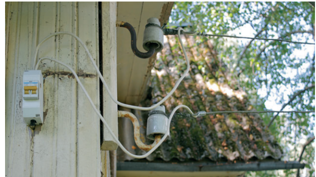
Рис. 1.10. Ввод электричества в деревянный дом
