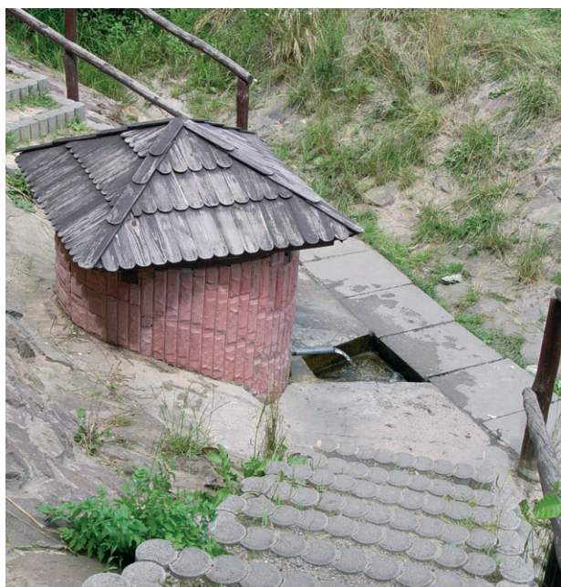
Рис. 3.7. Обустройство ключевого колодца
