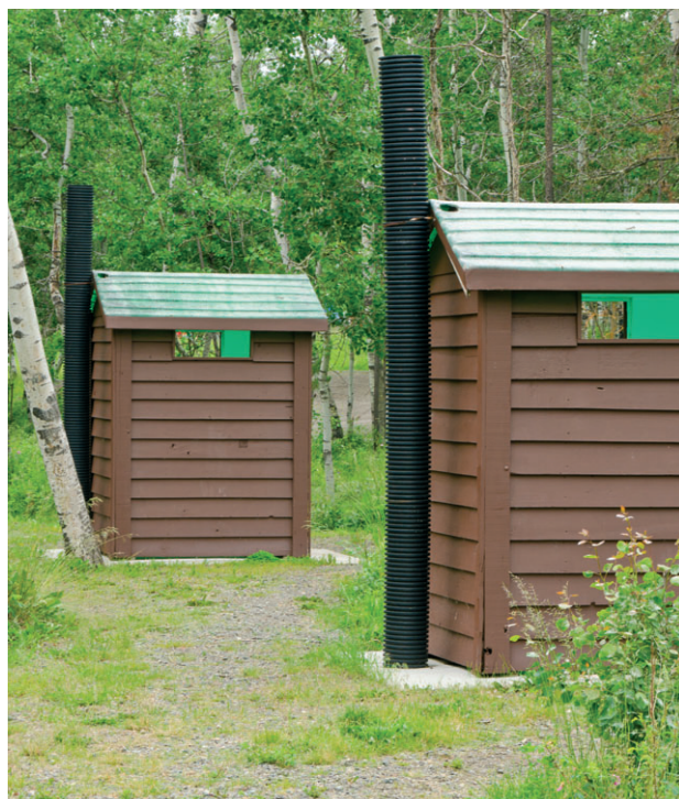
Рис. 7.19. Сухой туалет. Устанавливается над выгребными ямами. Используются также специальные съемные кассеты. Нечистоты обрабатываются с помощью порошкообразных веществ без воды.
