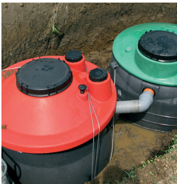
Рис. 8.10. Заводской септик из прочного полиэтилена
