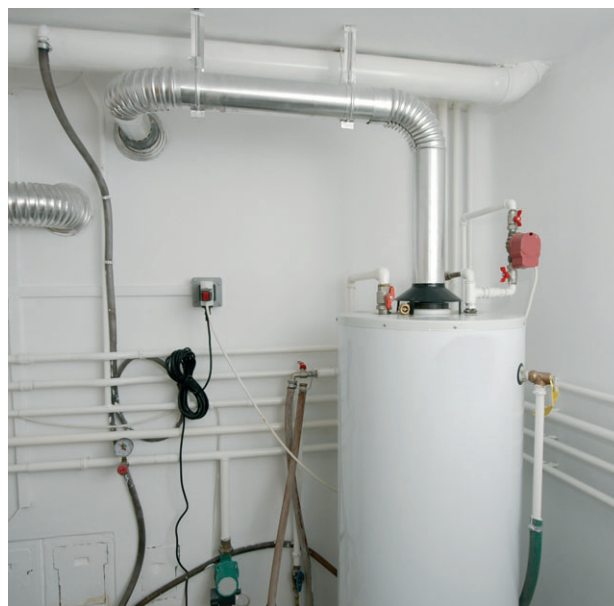
Рис. 11.1. Автономная современная система водяного отопления в частном доме
