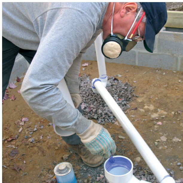
Рис. 4.13. Монтаж системы трубопровода из поливинилхлорида с помощью клея
