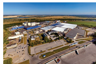
Завод «Проктер энд Гэмбл», г. Новомосковск
