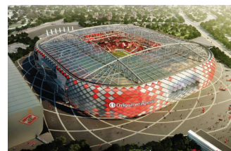
Футбольный стадион «Открытие Арена», г. Москва
