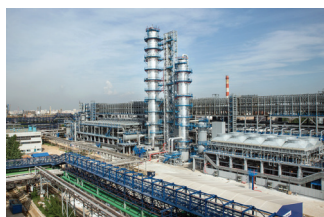
Газпромнефть-МНПЗ, г. Москва
