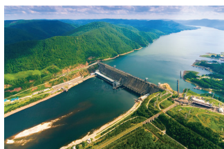
Красноярская ГЭС, г. Дивногорск
