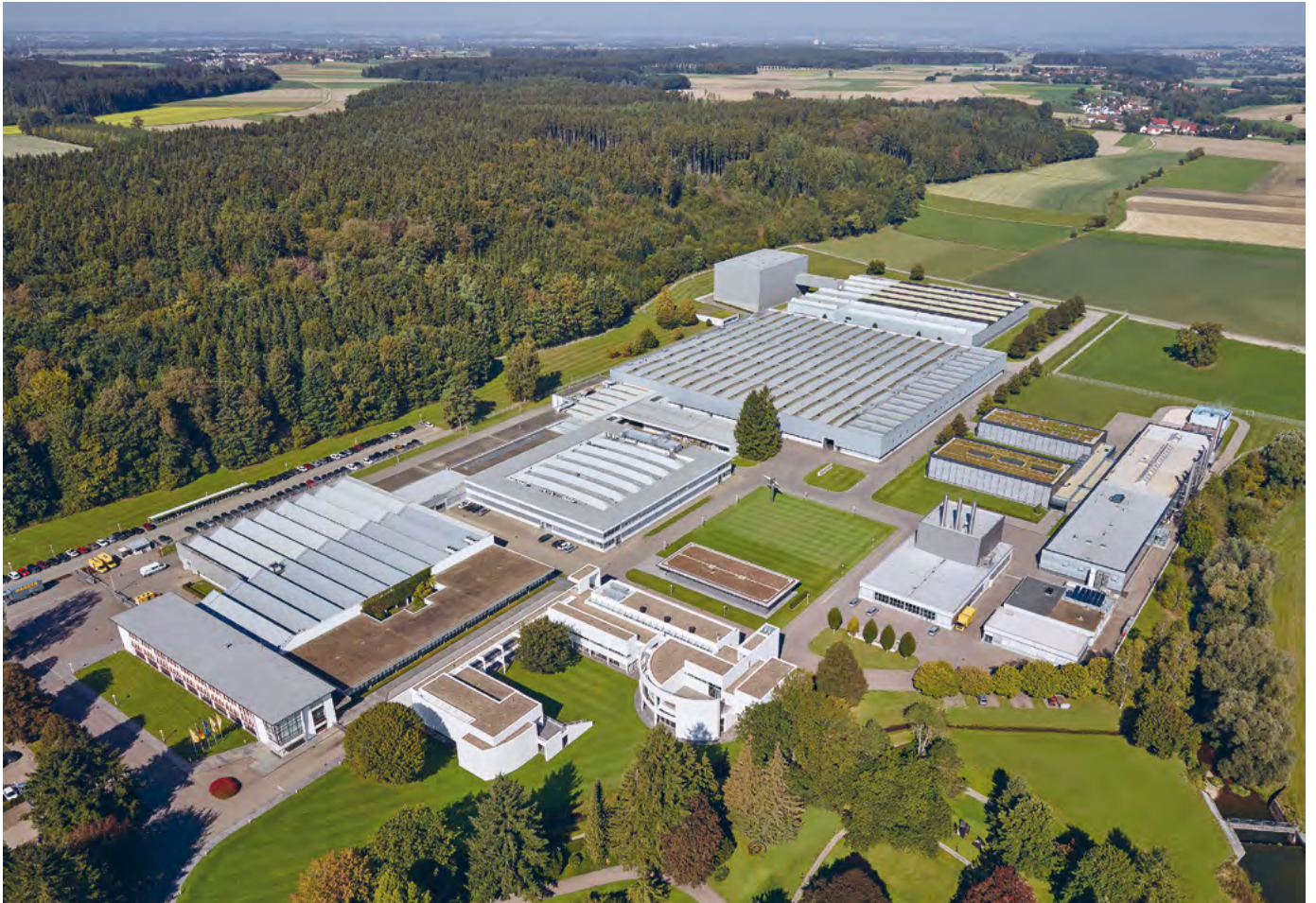
Завод Weishaupt, г. Швенди, Германия
