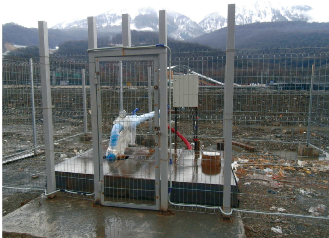
Рис. 25. Фото скважины ТНУ
