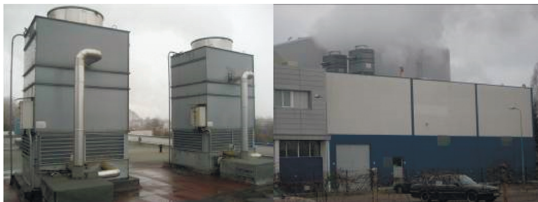
Рис. 37. Градирни открытого типа теплоцентрали "Imanta"
