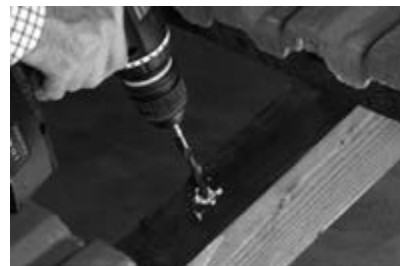
Шаг 2. Сверление отверстия в стропиле
