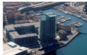
A FILO D'ACQUA RESIDENCE, SAVONA - ITA
