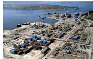
STADOL REFINERY, KÅRSTØ - NOR
