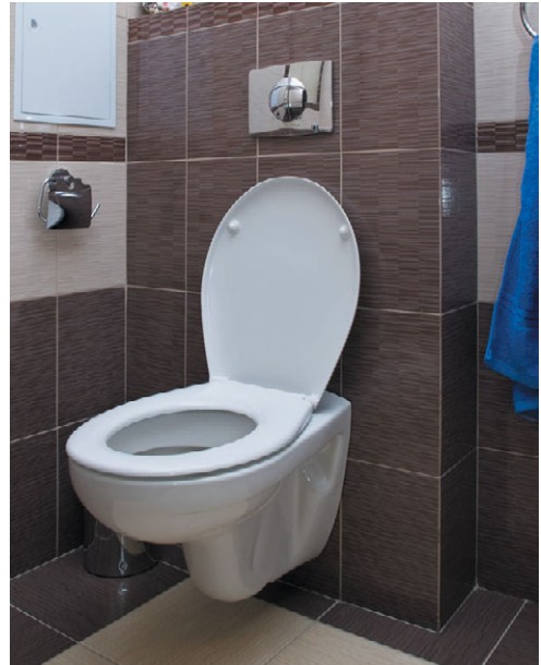
Рис. 10.122. На стене от бачка остается лишь декоративная клавиша для смыва воды
