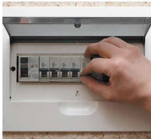
Рис. 10.274. Отключение щитка перед началом соединения
