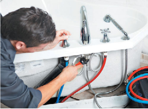
Рис. 2.7. Самостоятельное проведение сантехнических работ
