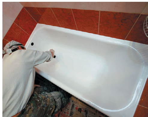
Рис. 11.89. Реставрация старой ванны с помощью эмали
