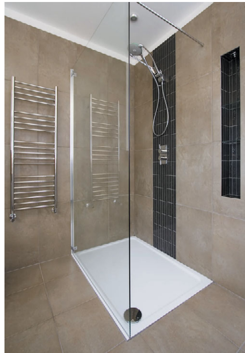
Рис. 10.209. Душевой угол — самый простой вариант душевой кабины
