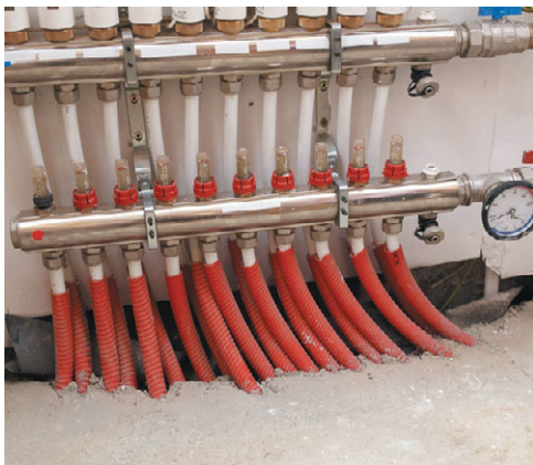
Рис. 12.11. Готовая стяжка и распределительная система пола
