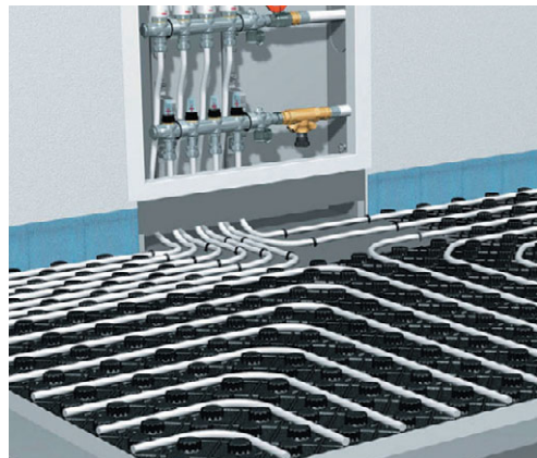
Рис. 12.12. Водяной теплый пол уложен
