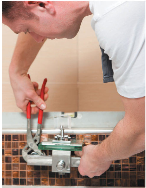
Рис. 11.26. Ремонт смесителя
