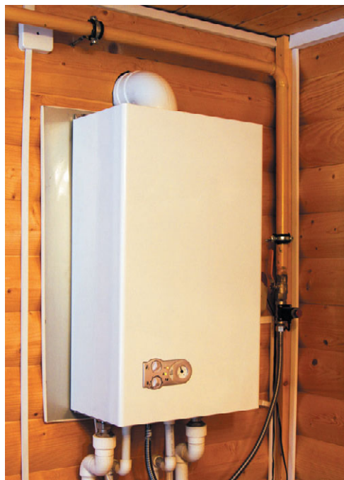
Рис. 3.1. Новые регламенты контролируют установку и эксплуатацию газового оборудования
