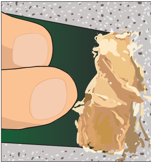
Рис. 1.54. Заполняем отверстие раствором
