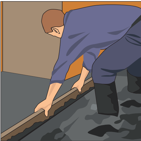
Рис. 12.5. Выравнивание стяжки правилом
