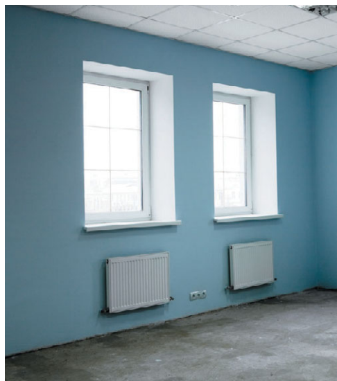
Рис. 12.50. Радиатор, установленный под окном, теряет 3–4 % тепла
