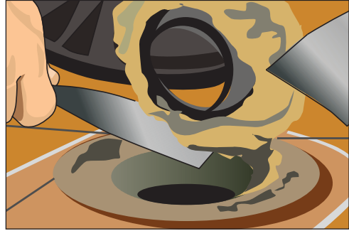
Рис. 10.86. Убираем старую резиновую прокладку при демонтаже унитаза с вертикальным выпуском вместо раструба
