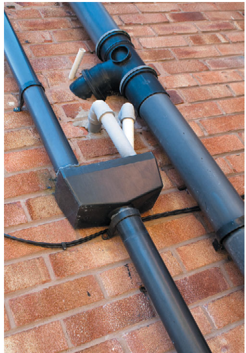
Рис. 5.4. Проложенные трубы с заделанными вокруг них пустотами
