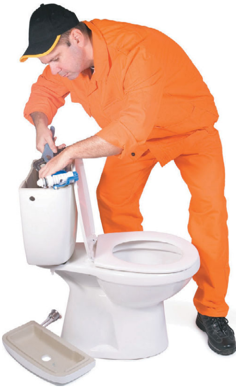
Рис. 11.63. Ремонт сливного бачка доступен не только сантехнику
