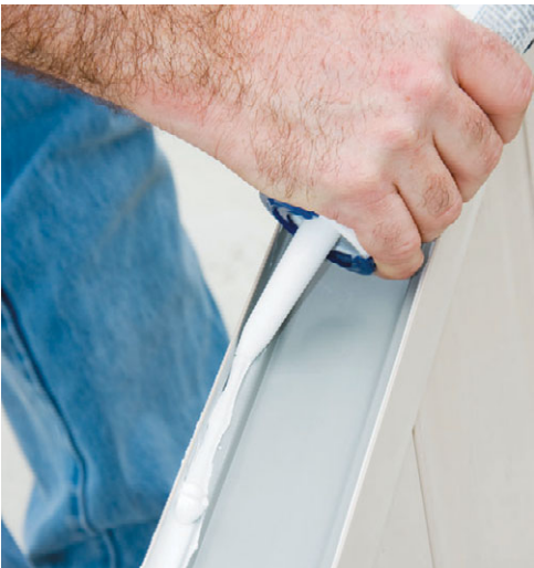
Рис. 1.35. Нанесение силиконового герметика
