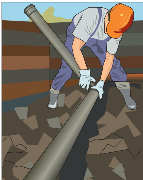
Рис. 8.37. Сборка труб в небольшие звенья по 3–4 штуки
