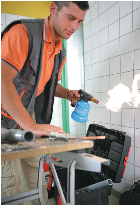
Рис. 4.53. Берем газовую горелку
