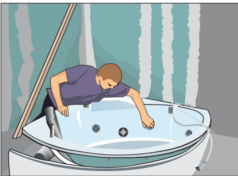
Рис. 10.190. Установка джакузи с декоративным экраном
