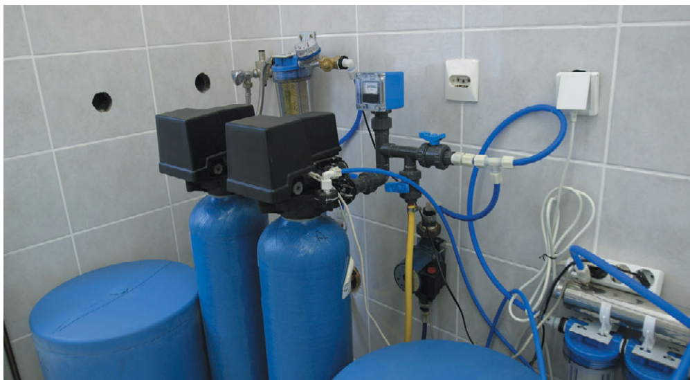
Рис. 7.1. Система многоступенчатой очистки воды
