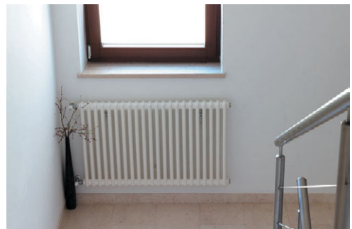
Рис. 12.42. Радиаторы располагают под окном
