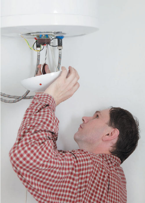
Рис. 10.265. Установка водонагревателя
