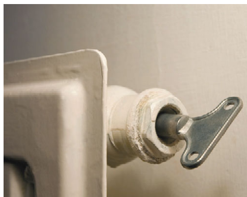
Рис. 12.52. Выпуск воздуха из радиатора (слева) с помощью специального крана (справа)
