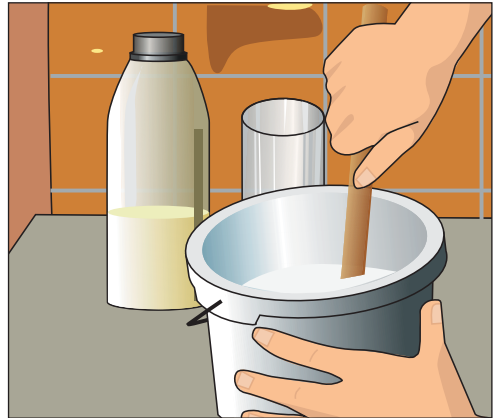
Рис. 11.104. Добавляем в основу отвердитель, тщательно перемешиваем в течение 10 мин
