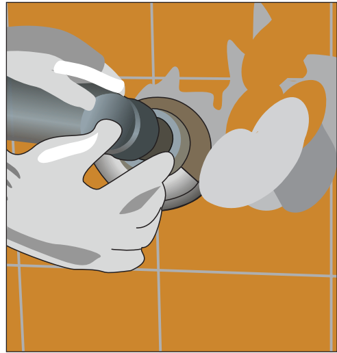
Рис. 10.37. Убираем старые шурупы с резьбой угловой шлифовальной машинкой с отрезным диском по металлу
