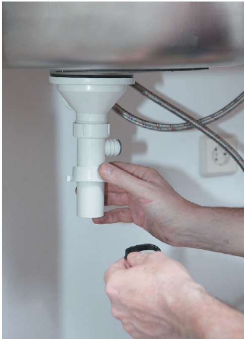
Рис. 10.76. Надеваем уплотнительное кольцо
