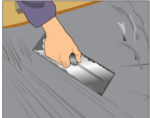
Рис. 12.6. Очистка застывшей цементной стяжки
