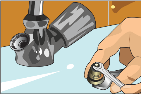
Рис. 11.36. Отвинчиваем уплотнительную гайку с помощью двух разных гаечных ключей, ставим новую прокладку и закрепляем гайкой
