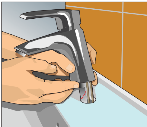
Рис. 10.28. Ставим смеситель в предназначенное отверстие умывальника
