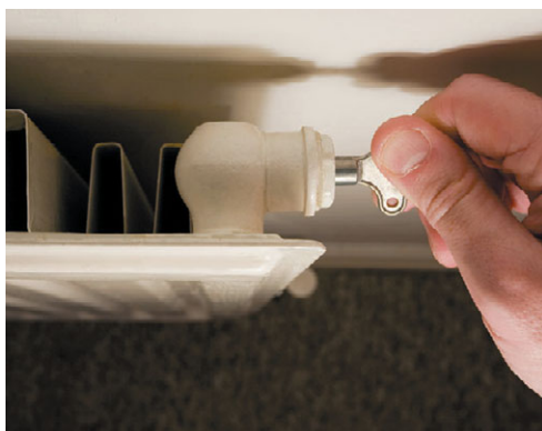
Рис. 12.52. Выпуск воздуха из радиатора (слева) с помощью специального крана (справа)
