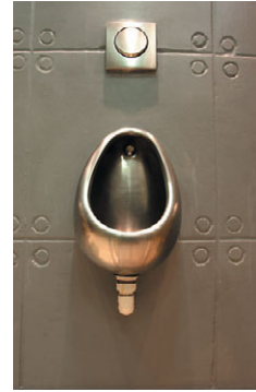
Рис. 10.125. Модель металлического писсуара со встроенным в стену бачком
