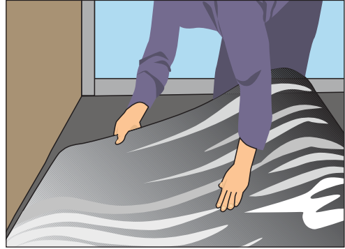
Рис. 12.16. Укладываем вспененный полиэтилен, покрытый алюминиевой фольгой
