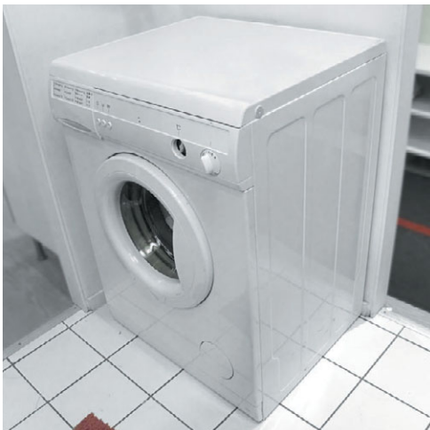
Рис. 10.232. Пол, покрытый керамической плиткой, — идеальный вариант для установки стиральной машины
