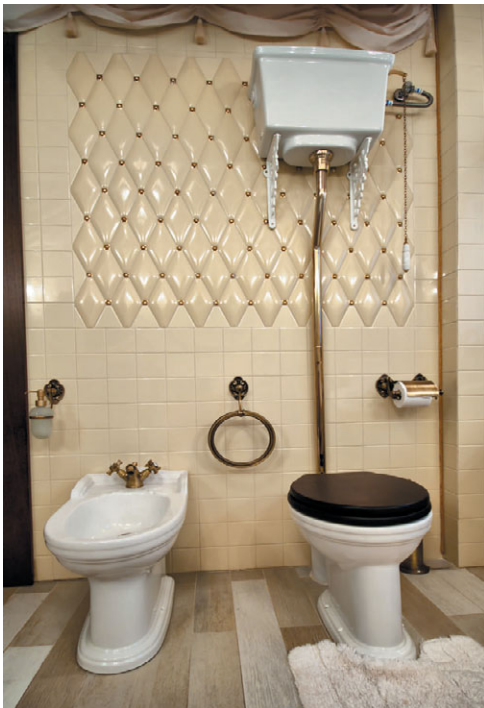
Рис. 10.93. Унитаз с подпотолочным бачком
