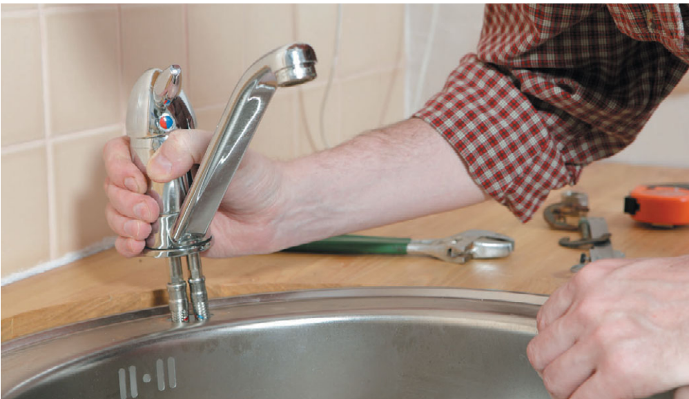
Рис. 10.14. Демонтаж старого смесителя на узкой основе
