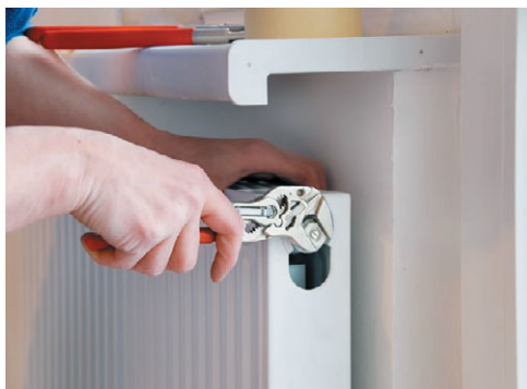
Рис. 3.3. Монтаж системы отопления
