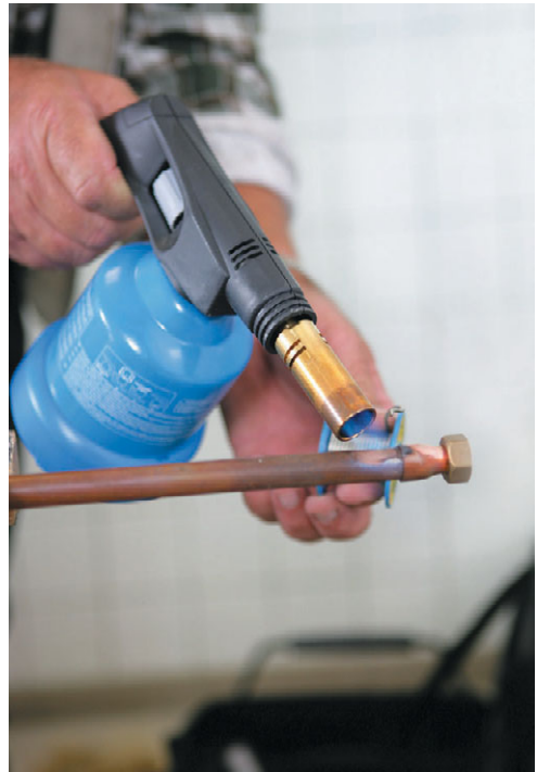
Рис. 4.55. Расплавляем припой в зазоре между фитингом и трубой
