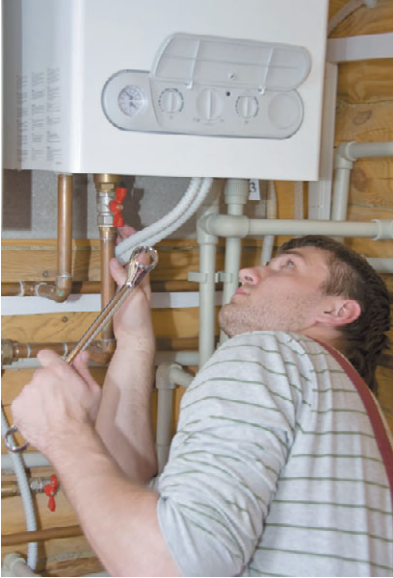
Рис. 10.288. Подключение нагревателя к водопроводу
