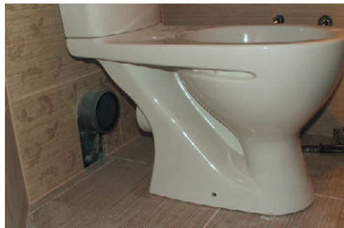
Рис. 10.88. Унитаз с горизонтальным выпуском
