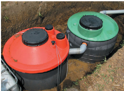
Рис. 8.25. Септик заводского производства из полиэтилена
