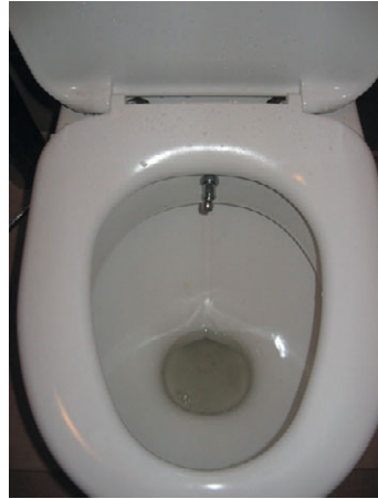
Рис. 10.153. Унитаз-биде (в центре — кран для подачи воды)
