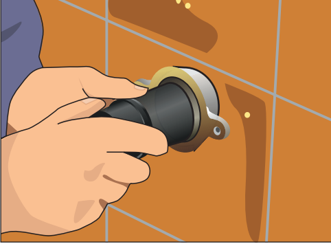
Рис. 10.132. Вставляем патрубок в раструб канализации, предварительно нанеся на него сурик
