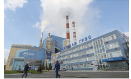
Рефтинская ГРЭС, Свердловская обл.
