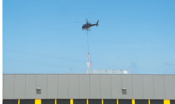
Установка на крышу складского помещения с помощью вертолета
