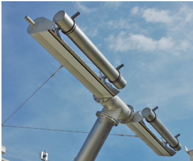
Труба забора очищенной воды декантера SBR-DECA
