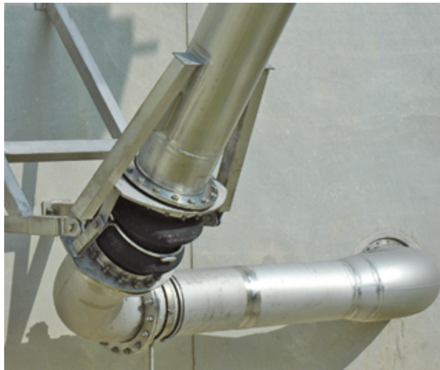
Колено между отводной трубой и декантером SBR-DECA
