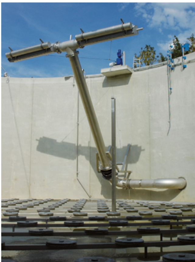
Декантер в комбинации с дисковыми аэраторами ELASTOX®-T.
