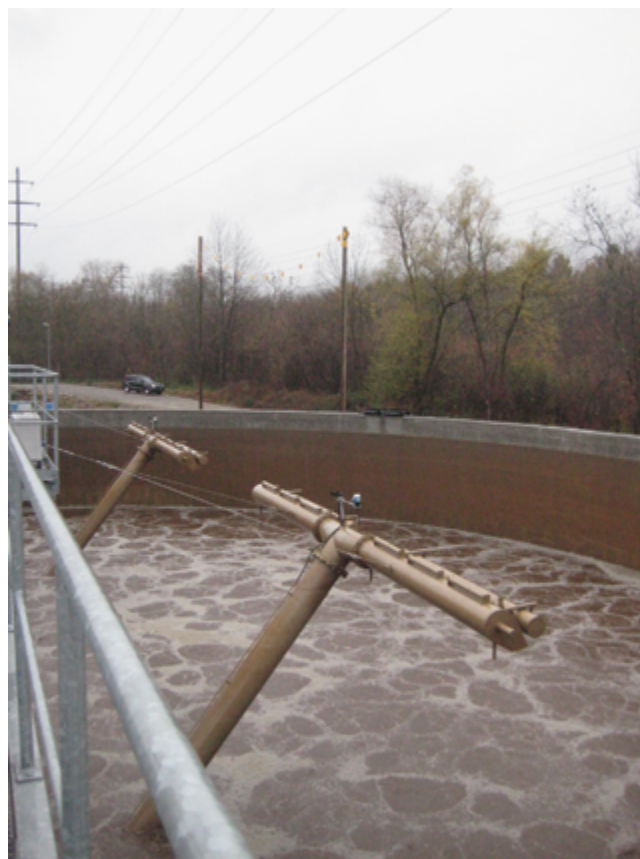
Комбинация нескольких параллельно работающих декантеров для большого объема отвода воды.
