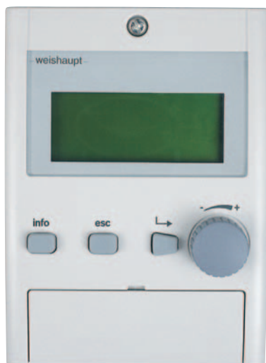
Блок управления и индикации для менеджера W-FM 100/ 200
