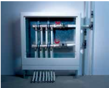
Подводка трубы к коллекторам
