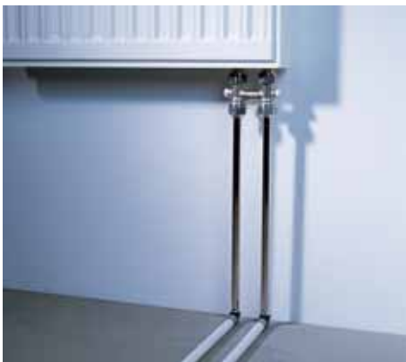
Подсоединение с помощью подводки для радиаторов
