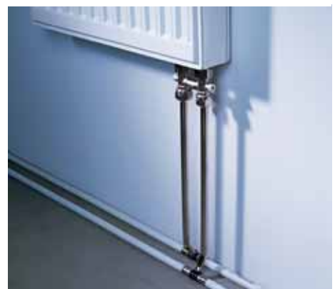
Подсоединение с помощью подводки для радиаторов
