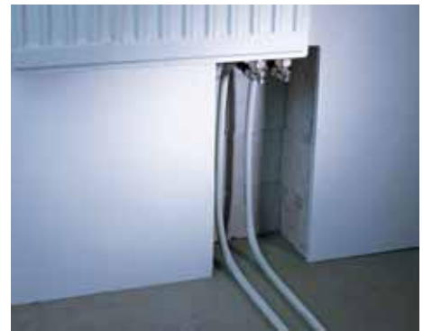
Непосредственное подключение трубы к радиатору
