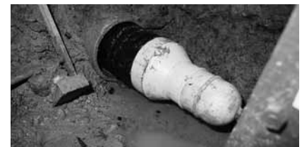
Рис. 11.2 Фотография носового конуса, приваренного стыковой сваркой
