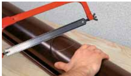
Рис. 14 Монтаж углов желоба
