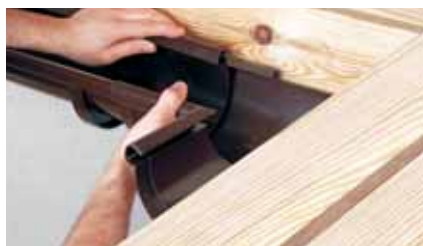
Рис. 14 Монтаж углов желоба
