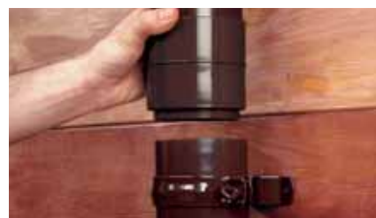
Рис. 20 Монтаж водосточной трубы при помощи муфты
