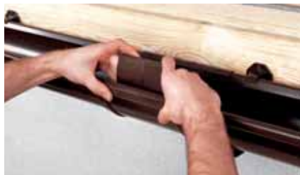
Рис. 12 Вырезание отверстия под воронку
