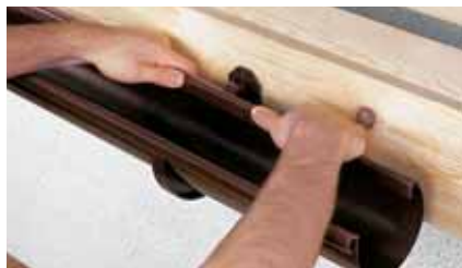
Рис. 10 Монтаж вкладки в муфту желоба
