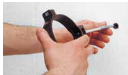
Рис. 21 Монтаж хомута к стене с утеплителем
