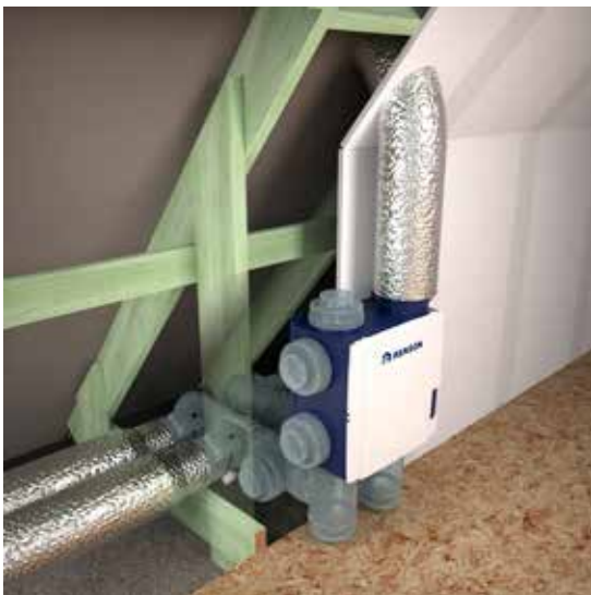
Аккуратный монтаж воздуховодов в пространстве треугольной формы
