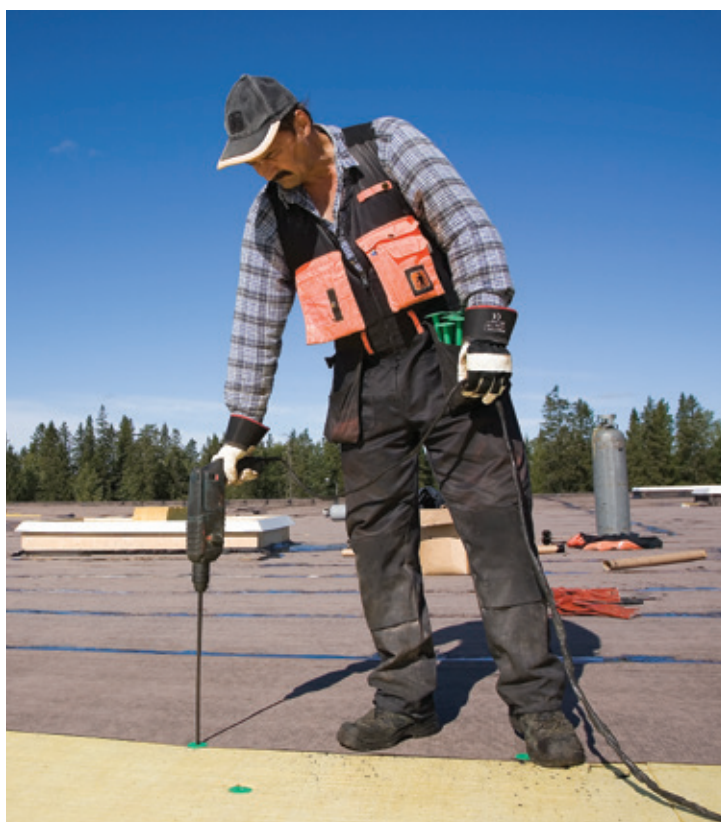
Монтаж на битумной кровле с помощью креплений Cרוco с регулируемым шурупом.
