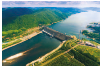
Красноярская ГЭС, г. Дивногорск
