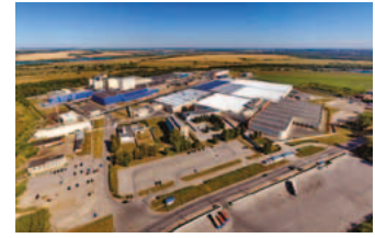
Завод «Проктер энд Гэмбл», г. Новомосковск
