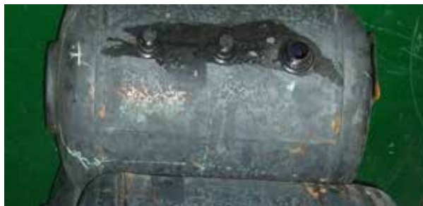
Три сварных шва на баках других производителей
