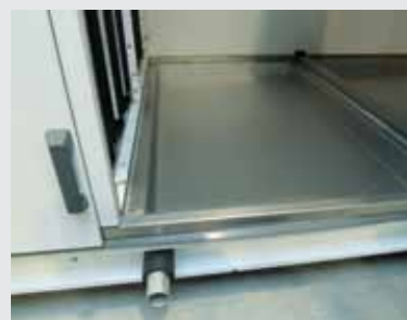
Поддон для стока конденсата из нержавеющей стали с возможностью наклона в двух направлениях, отвечающий требованиям соответствующих стандартов
