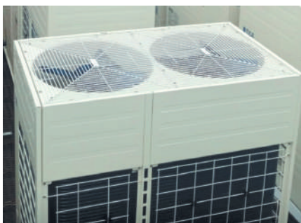
Решетки вентиляторов имеют обтекаемую форму
