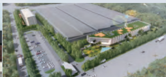
Производственная база в Гуанчжоу
