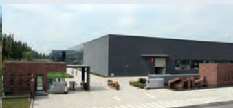
Производственная база в Тяньцзине
