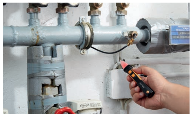
Проверка питания в распределительном щитке с testo 745
