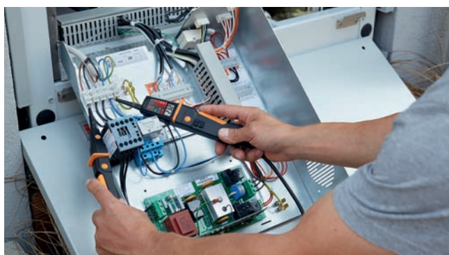
Измерение напряжения на компрессоре
