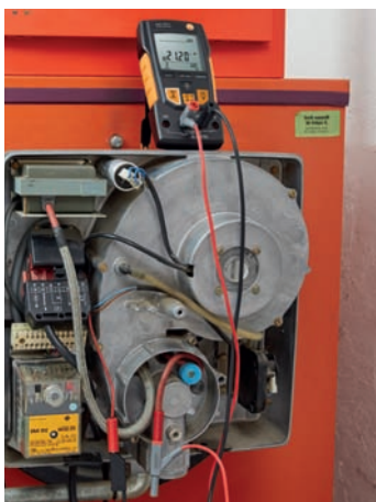
Измерение потока ионизации с testo 760
