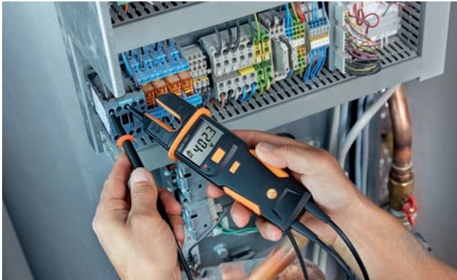
Проверка напряжения на тепловом насосе с testo 755
