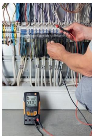
Проверка напряжения в распределительном щитке
