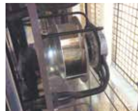
Секция вентилятора с ЕС-двигателем
