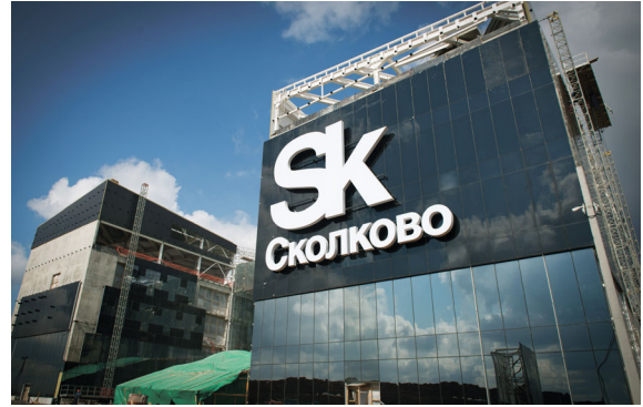
Технопарк «Сколково», Москва Воздухообрабатывающие агрегаты, вентиляторы
