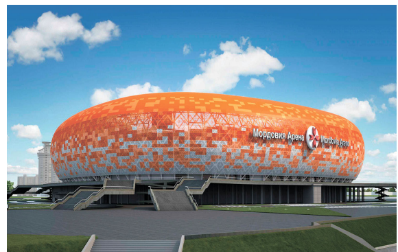
Спорткомплекс «Мордовия Арена», Саранск Вентиляторы, воздушные завесы
