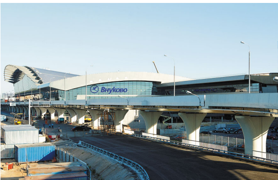
Аэропорт «Внуково», г. Москва Вентиляторы дымоудаления
