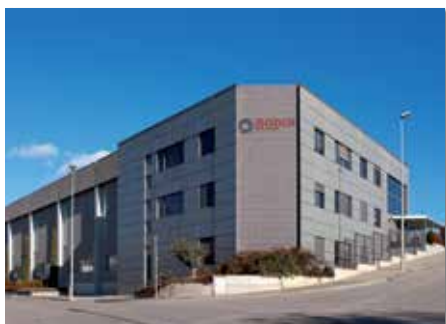
● Завод в Торелло (Испания)
